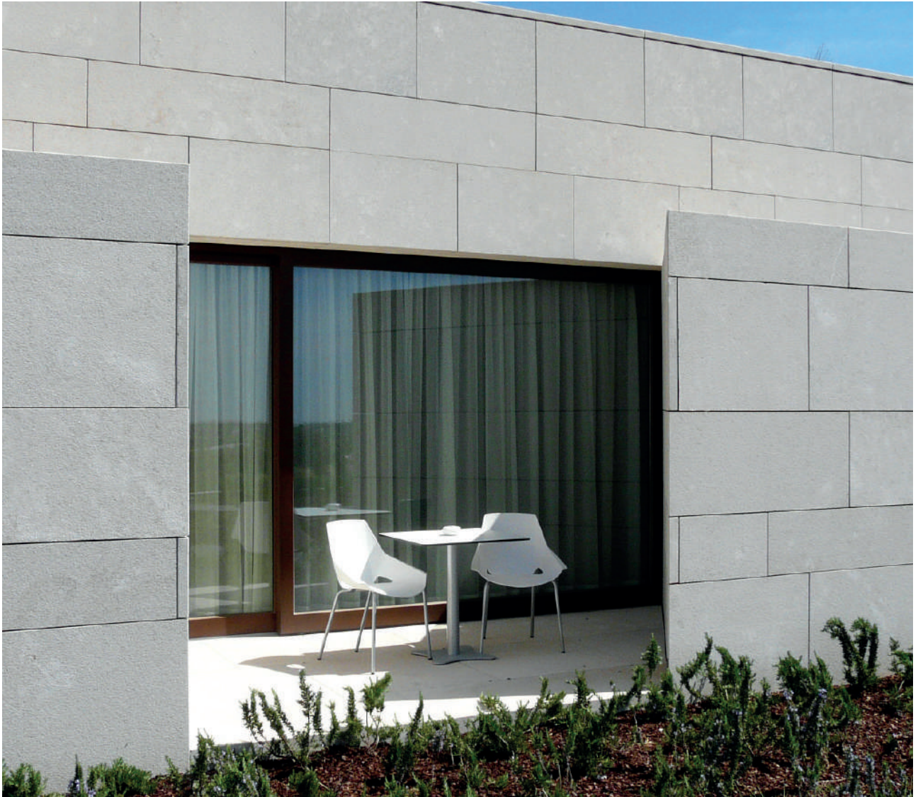
Puerta corredera elevable en la parte moderna del Palácio de Estoi. Lift and slide door in the modern part of Palácio de Estoi.
